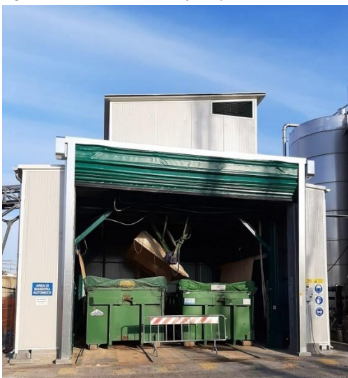
Figura 11 Particolare della filtropressa
