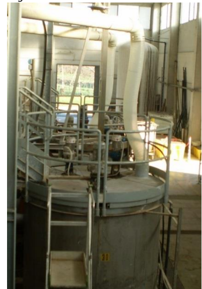
Figura 8 Reattore di miscelazione 1
